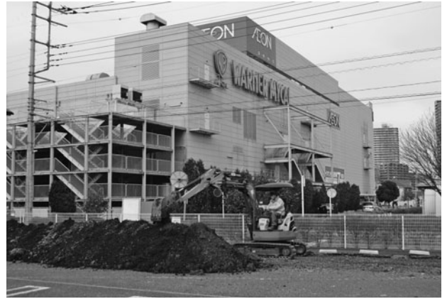
東中学校西遺跡第 15 地点調査風景
