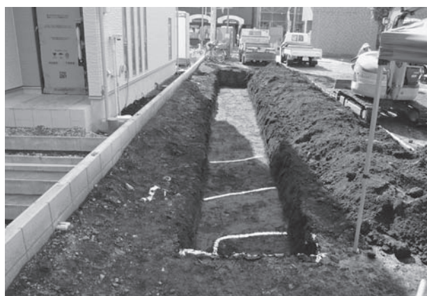
江川東遺跡第 23 地点トレンチ 1
