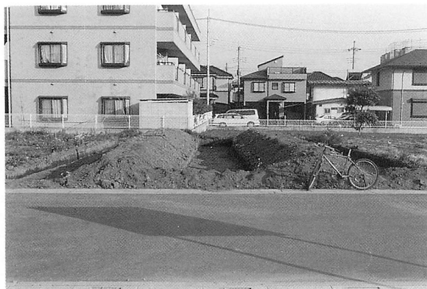
東久保南遺跡第18地点試掘全景
