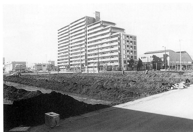
東久保第22地点調査区南側全景（試掘調査）
