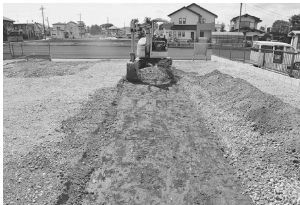
福岡新田遺跡第 2 地点調査風景
