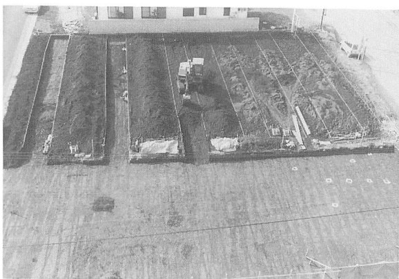
トレンチ 表土除去風景
