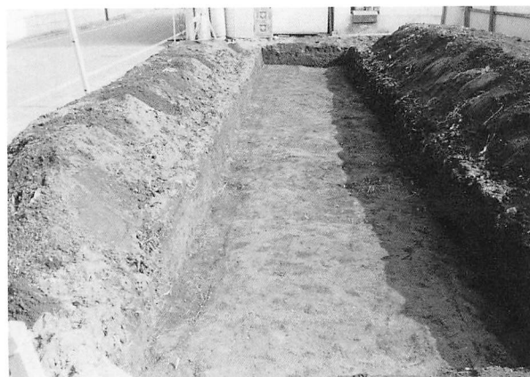
中沢前遺跡第20地点試掘調査
