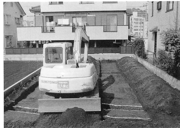
中沢前遺跡第24地点試掘調査
