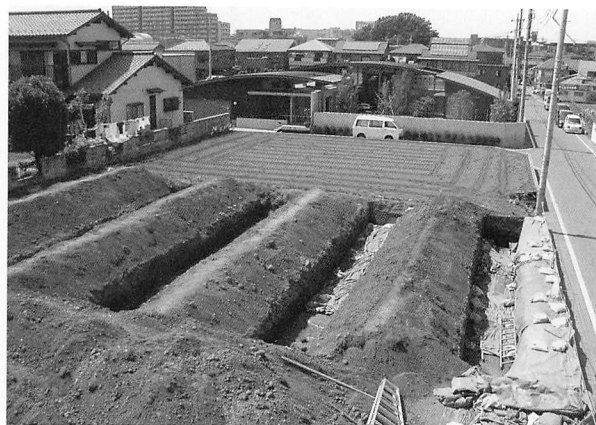
西ノ原遺跡第128地点試掘調査
