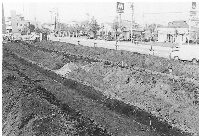
西ノ原遺跡第92地点調査区全景
