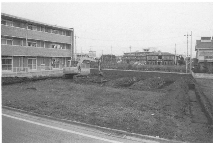
西ノ原遺跡第111地点 調査区全景
