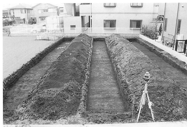
東久保南遺跡第23地点調査区全景
