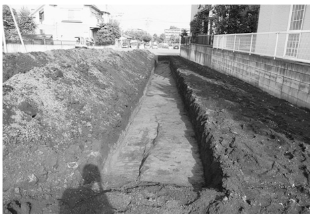
西ノ原遺跡第 154 地点トレンチ 5
