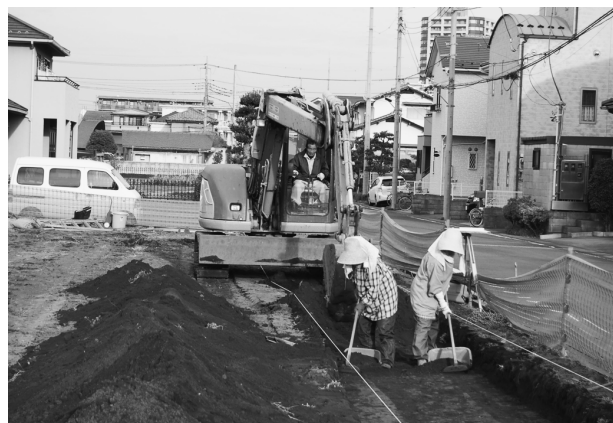
西ノ原遺跡第 157 地点調査風景
