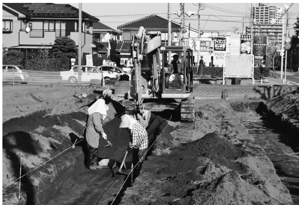
西ノ原遺跡第 156 地点調査風景
