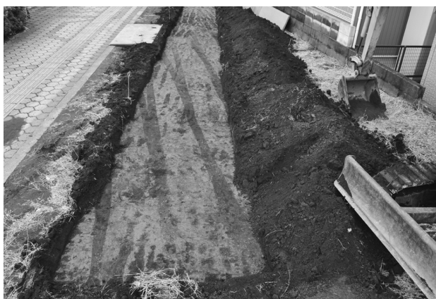
西ノ原遺跡第 168 地点トレンチ
