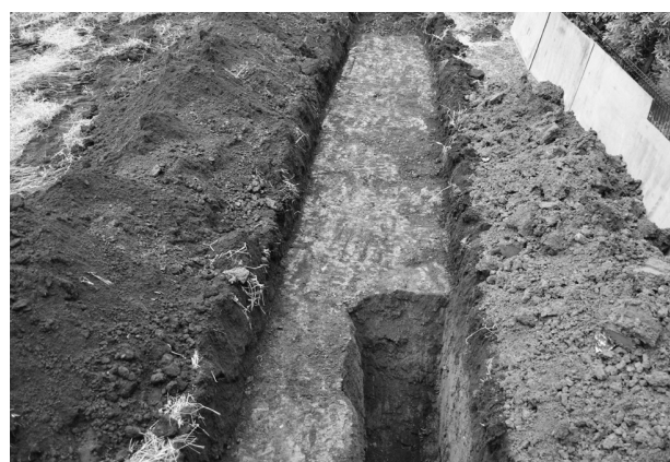
西ノ原遺跡第 155 地点トレンチ 1
