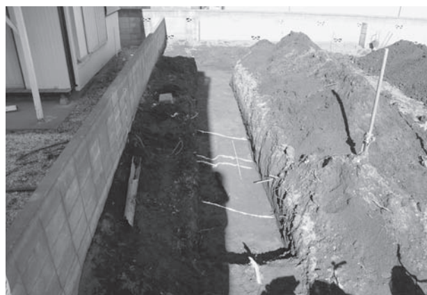
西ノ原遺跡第 163 地点トレンチ 1
