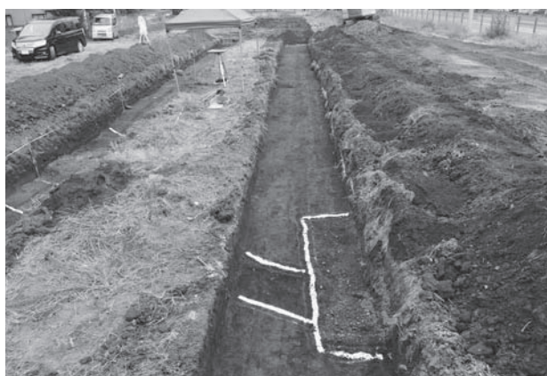
西ノ原遺跡第 162 地点トレンチ 5
