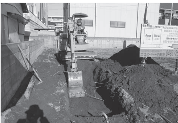
西ノ原遺跡第 163 地点調査風景
