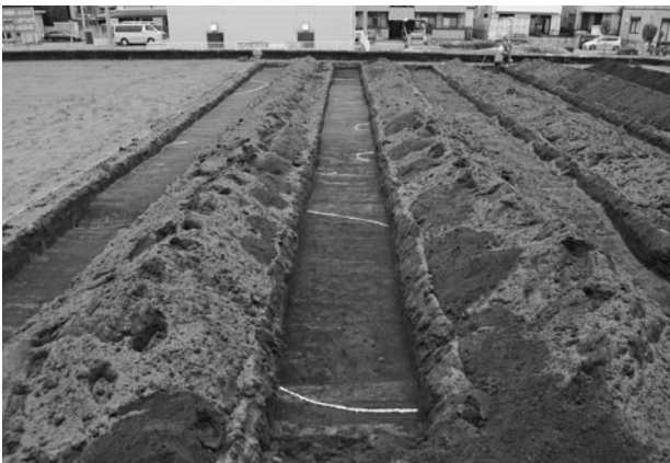
西ノ原遺跡第 159 地点トレンチ 2
