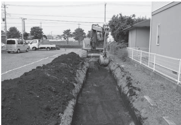
西ノ原遺跡第 161 地点調査風景
