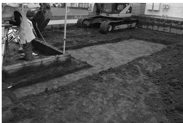
西ノ原遺跡第 180 地点トレンチ 2
