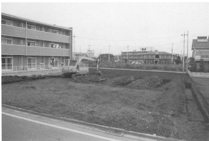
西ノ原遺跡第111地点 調査区全景
