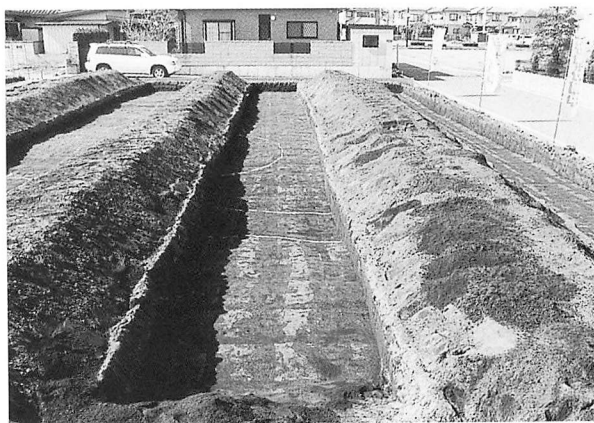
西ノ原遺跡第122地点トレンチ 4
