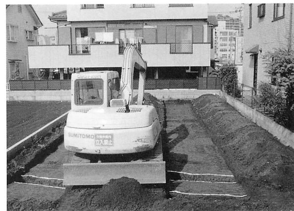
中沢前遺跡第24地点試掘調査
