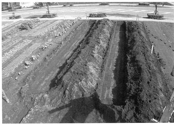
西ノ原遺跡第131地点試掘調査
