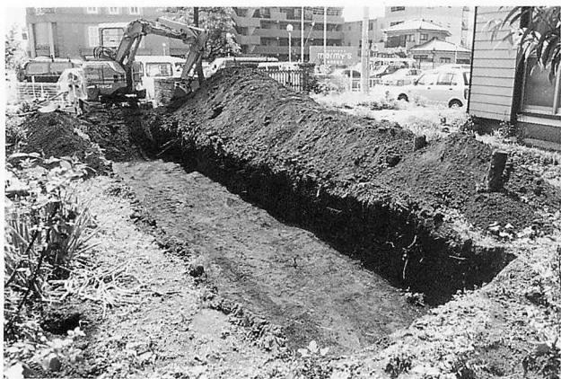
中沢前遺跡第22地点調査区全景
