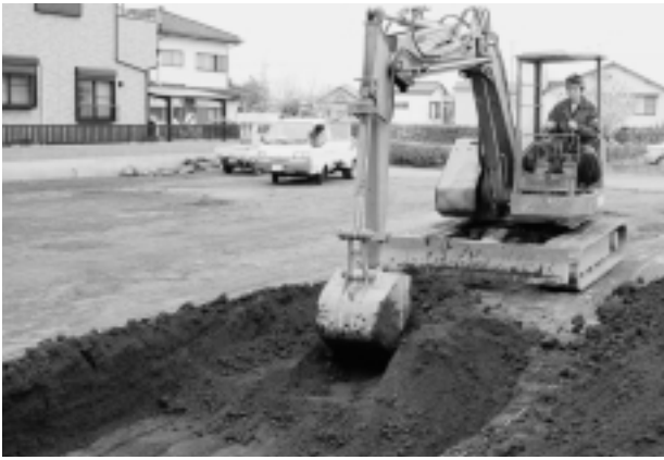
苗間東久保遺跡第24地点調査風景
