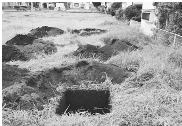
苗間東久保遺跡第 28 地点トレンチ 4
