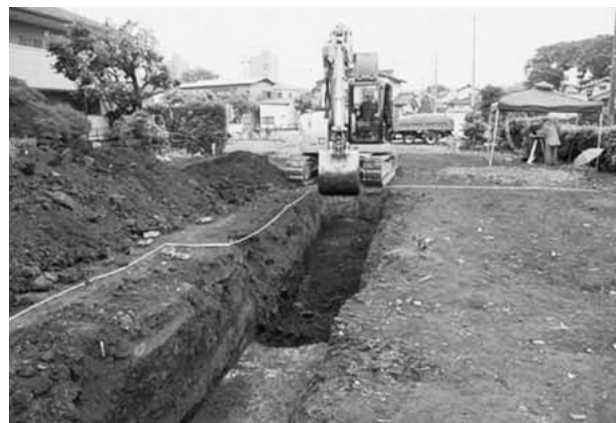
浄禅寺跡遺跡第 25 地点調査風景
