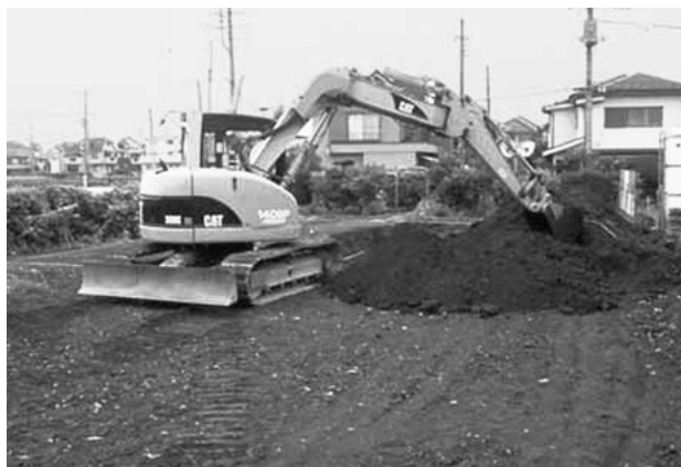
浄禅寺跡遺跡第 25 地点調査風景
