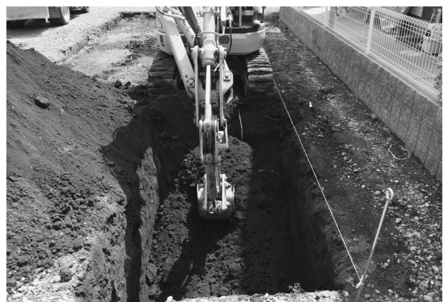
大井宿遺跡第 17 地点調査風景
