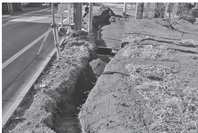
浄禅寺跡遺跡第 46 地点トレンチ 1
