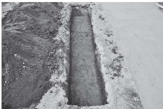
浄禅寺跡遺跡第 45 地点トレンチ 1
