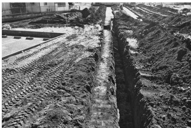
浄禅寺跡遺跡第 56 地点トレンチ 3
