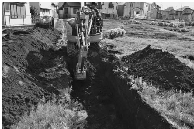
浄禅寺跡遺跡第 56 地点表土除去
