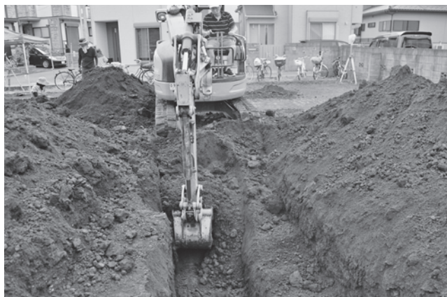
浄禅寺跡遺跡第 58 地点調査風景
