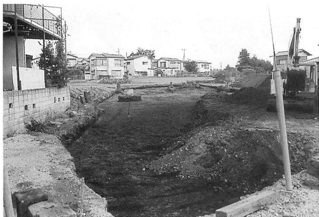
浄禅寺跡遺跡第19地点表土除去風景
