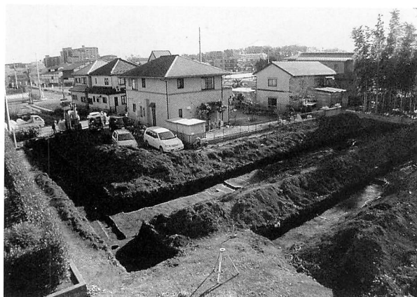
大井宿遺跡第11地点試掘調査
