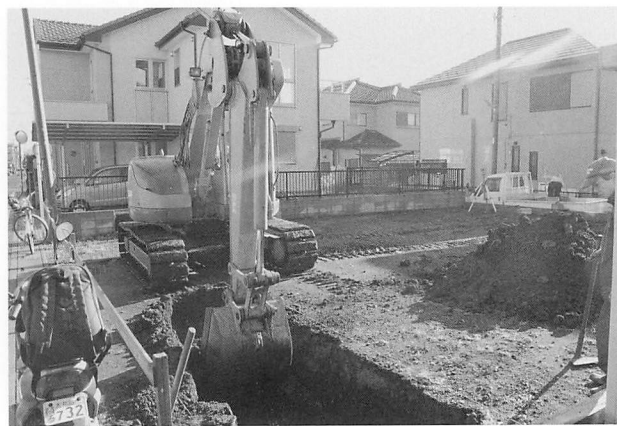
本村遺跡第 120 地点調査風景
