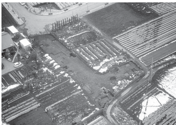
第3地点 全景 (航空写真)
