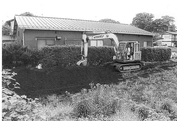
大井氏館跡遺跡第12地点表土除去風景
