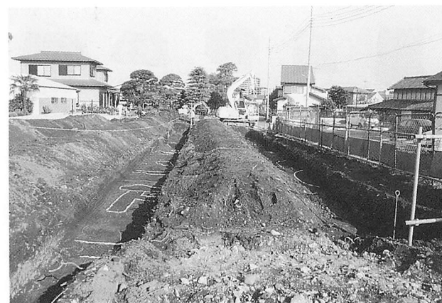
大井宿遺跡第5地点調査区全景
