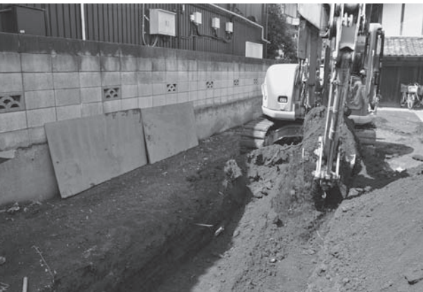
大井氏館跡遺跡第 24 地点調査風景
