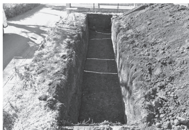
大井氏館跡遺跡第 25 地点トレンチ
