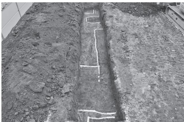
大井氏館跡遺跡第 27 地点トレンチ 1
