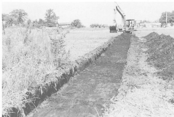
8地点作業風景
