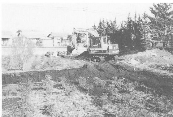
11地点作業風景
