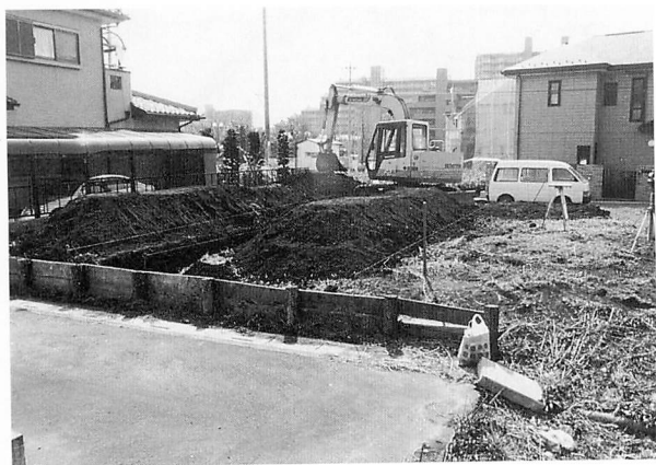
本村遺跡第67地点近景
