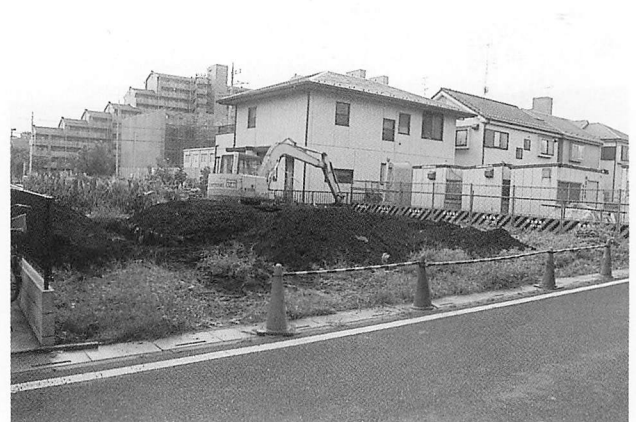
本村遺跡第78地点試掘近景
