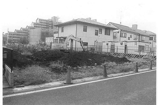
本村遺跡第78地点試掘近景
