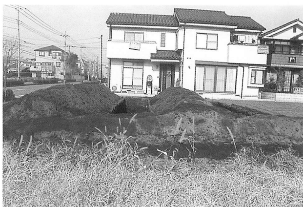
本村遺跡第83地点試掘近景
