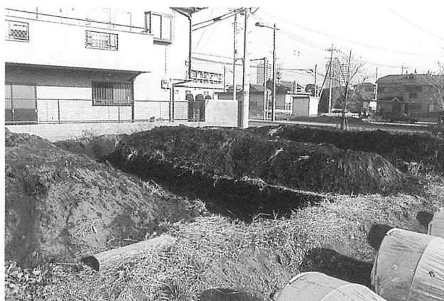
本村遺跡第81地点試掘近景
