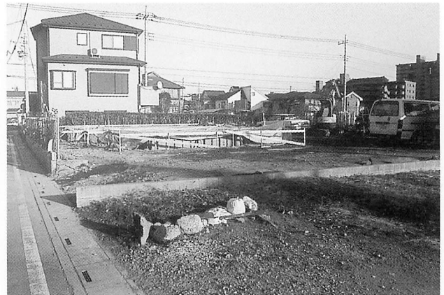
本村遺跡第85地点試掘近景
