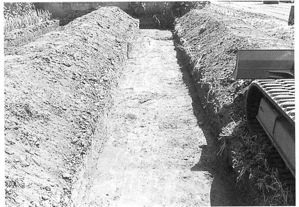
本村遺跡第97地点トレンチ 2
