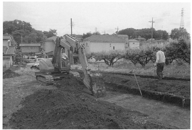
小田久保遺跡第 7 地点調査風景
